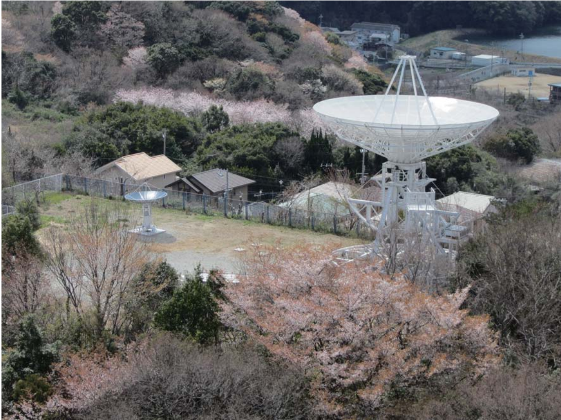
電波観測通信施設 3m (左) と12m (右) パラボラアンテナ
