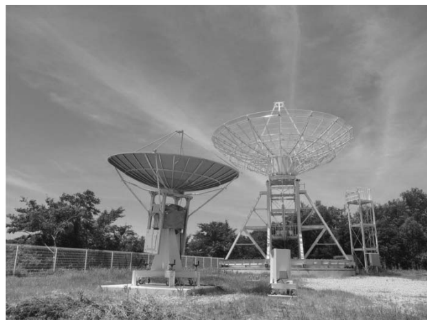
図1 12mアンテナと3mアンテナ(和歌山大学キャンパス 電波観測通信施設)
