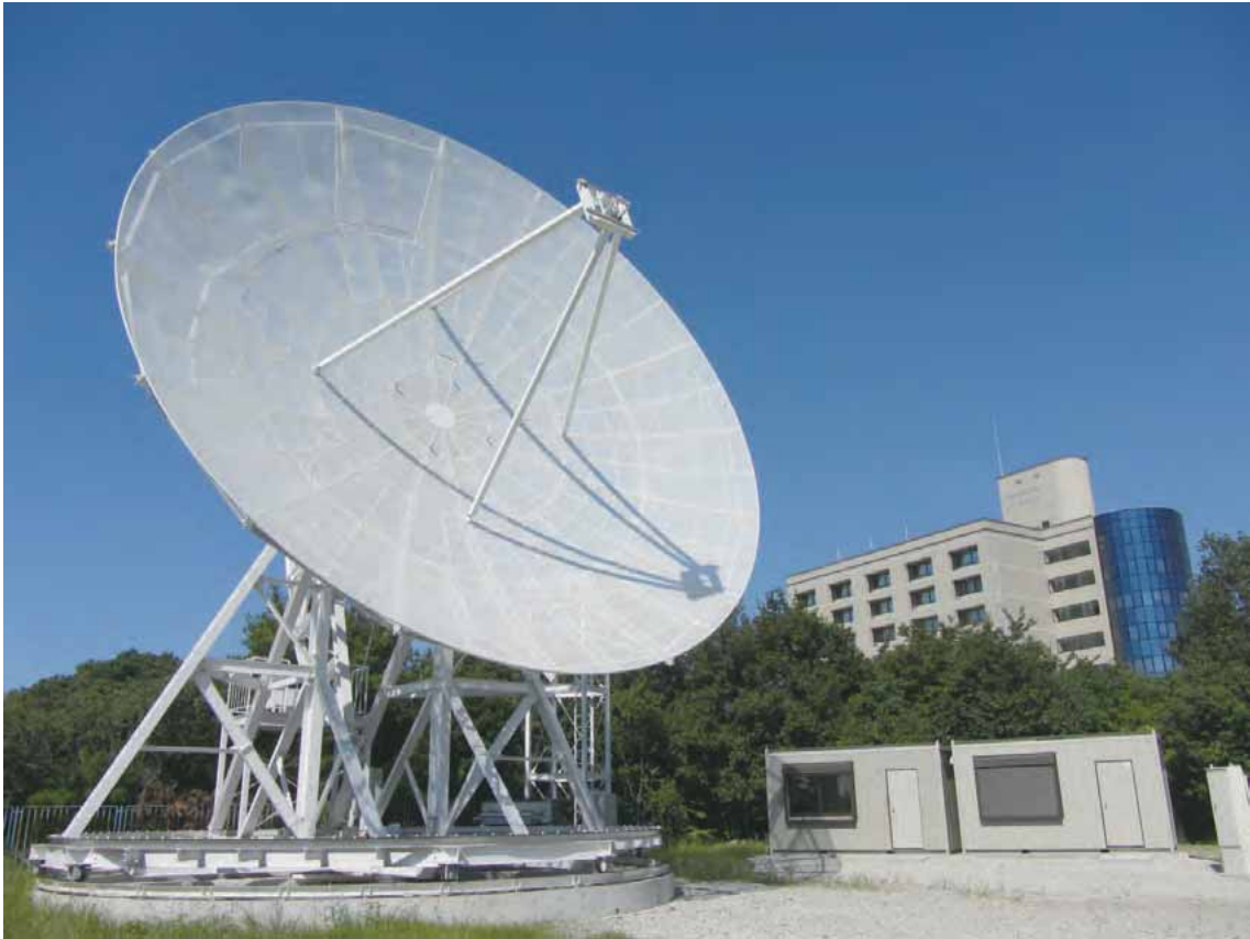
電波観測通信施設 12m パラボラアンテナ
