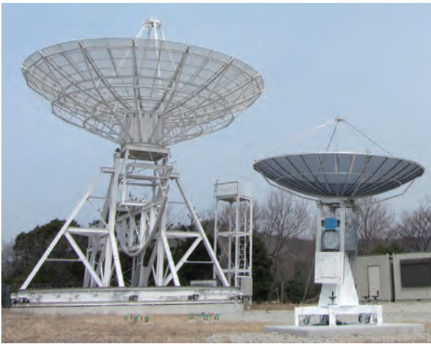
図2 右側：3m Sバンドアンテナ 左側：12m, Xバンドアンテナ
