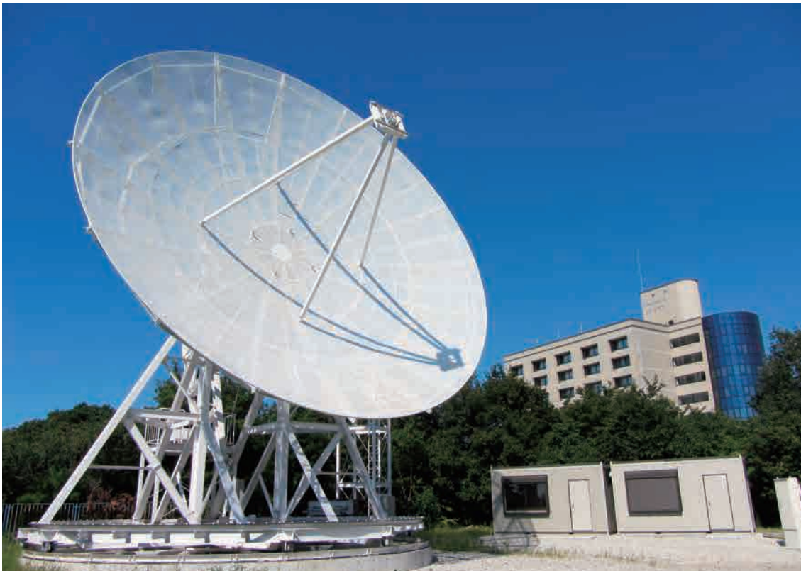
電波観測通信施設 12mパラボラアンテナ
