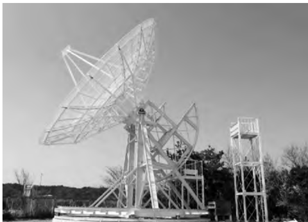
図1 和歌山大学12mパラボラアンテナ
